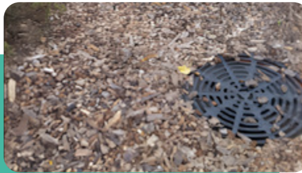
→ Regard vers réseau de connexion des noues d'infiltration
