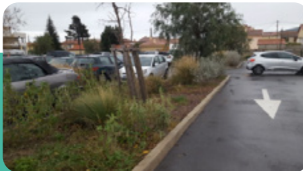
→ Noue d'infiltration sur le parking
