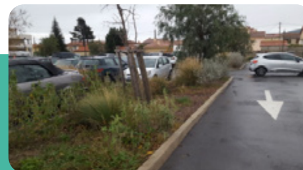
→ Noue d'infiltration sur le parking
