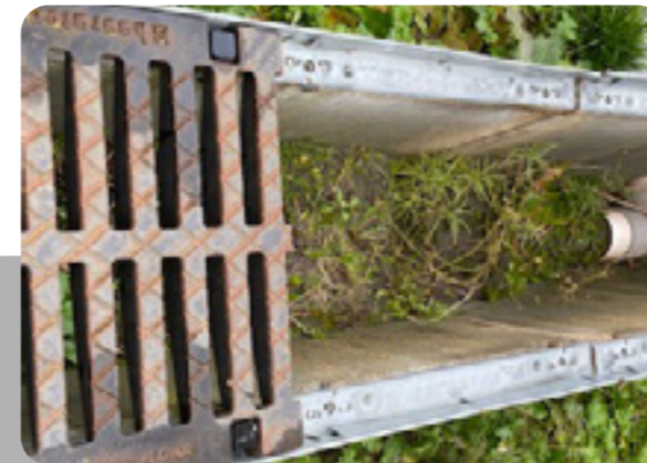
→ La tranchée d'infiltration
