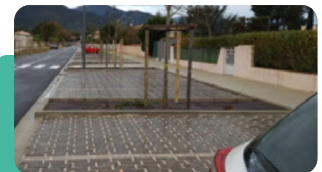
→ Places de stationnement en pavés et graviers
