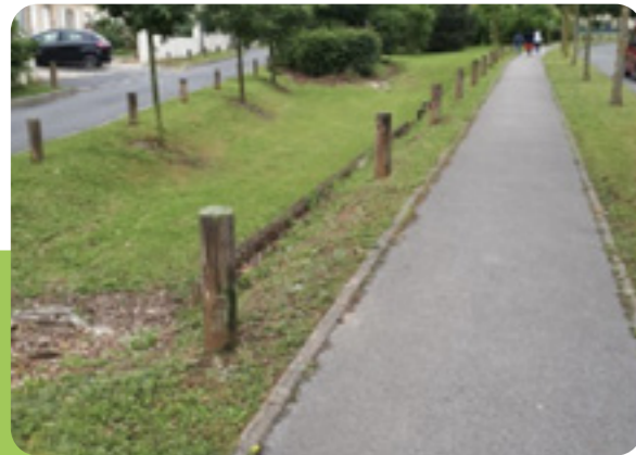
→ La noue d'infiltration
