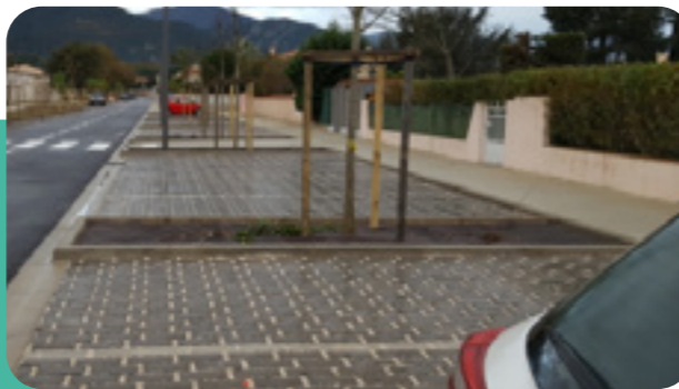
→ Places de stationnement en pavés et graviers
